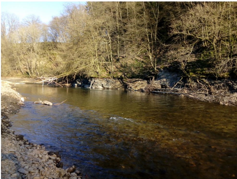
Abbildung 5: Die Wasserkraftanlage Ohl Grünscheid oberhalb von der Anlage Ehreshoven I steht still, der Stau ist abgelassen und die Agger fließt wieder in ihrem alten Bett. Das soll auch so bleiben! (Bild: Friedrich Meyer).
