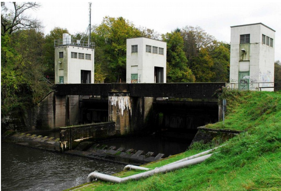
Abbildung 1: Wehr Ehreshoven I an der Agger in Engelskirchen. Bis hierhin kommen die Wanderfische aus der Nordsee. Durch die Rohre im Bild rechts werden 500l/Sek in das alte Aggerbett aus dem darüber liegenden Stau eingeleitet. Viel zu wenig für das als Zielartengewässer ausgewiesene alte Aggerbett, das eigentlich ein ideales Lachshabitat wäre. Obwohl der Gemeinderat von Engelskirchen und der Naturschutz schon seit Jahren eine vernünftige Mindestwassermenge fordern, sieht sich das Ministerium nicht in der Lage, diese durchzusetzen. (Bild: Friedrich Meyer).
