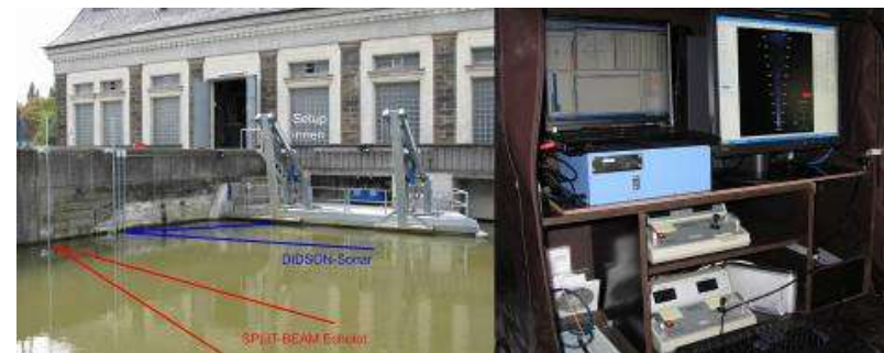
Projektdurchführung am Kw Hamm-Uentrop
